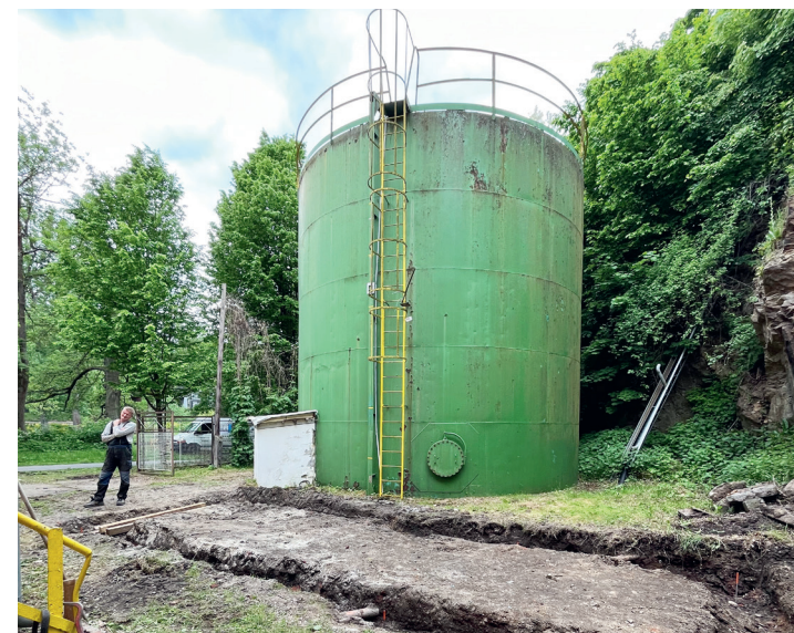
Základy pro novou chladicí jednotku se budují u vodního rezervoáru.
